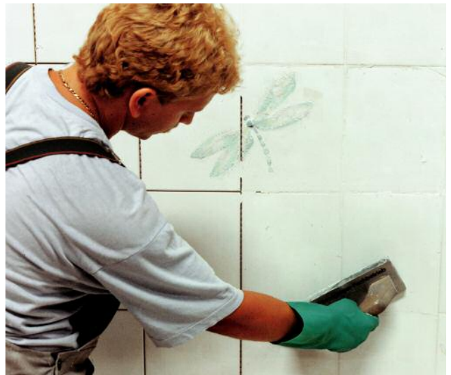
Mit PCI FT-Fugengrau und PCI FT-Fugenweiß können Fugen von 2 bis 8 mm Fugenbreite rissfrei verfugt werden.
