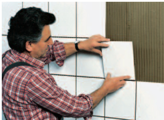
Funktionssichere Plattenverlegung im Dünnbettverfahren mit PCI FT-Klebemörtel.
