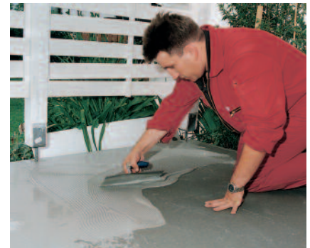
Die PCI Seccoral-1K-Abdichtung kann an Wand und Boden gestrichen oder gespachtelt werden.
