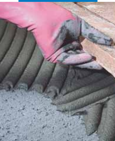
Verlegung von handgefertigten Terrakottafiesen auf Estrich
