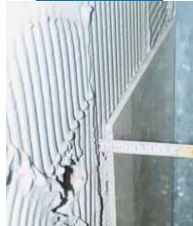
Ansetzen von Feinsteinzeug an der Wand
