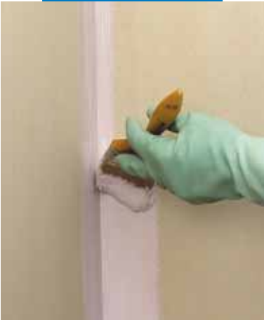
Verarbeitung von Mapegum WPS mittels Pinsel
