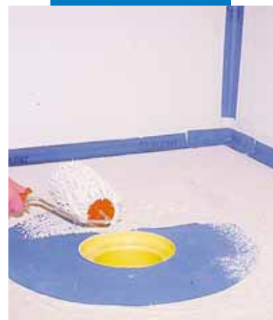
Eindichten der Dichtmanschette mit Mapegum WPS
