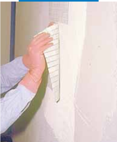
Ansetzen von Glasmosaik
