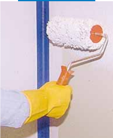
Auftragen von Mapegum WPS an der Wand mittels Rolle
